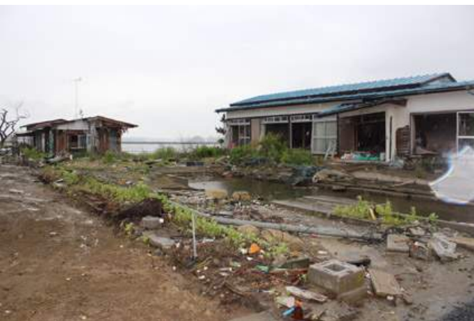
個人家屋の復旧はまだまだこれから先の作業
