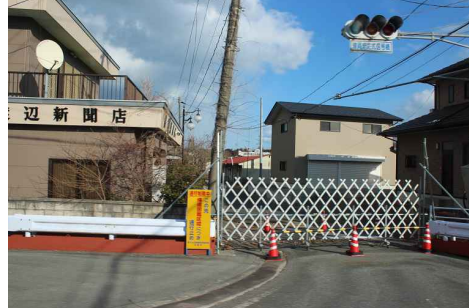
通り沿いの店舗、住宅、脇道の全てに張りめぐらされたバリケード。人的被害によるものか、荒れ果てた店舗も
